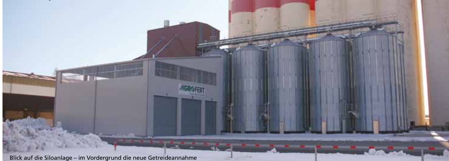
Blick auf die Siloanlage – im Vordergrund die neue Getreideannahme
